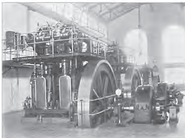
Херсонская городская электрическая станція. (2 двигателя по 200 л. с. и 1—90 л. с.)
