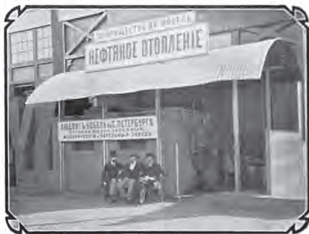
На Московской выставкѣ 1882 г. Котель, отопляемый нефтью.
