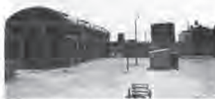
Насосная станція Завода ж. д. оборудованная двигателями Дизеля.
