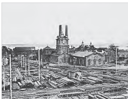
Центральная электрическая станция Коломенского завода
