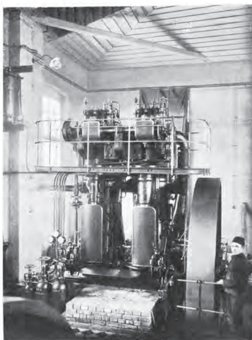
Электрическая городская станция въ г. Могилевъ. На рисунокъ представлень одинъ изъ двухцилиндровыхъ двигателей. Всего установлено на станціи въ 1909, 1910 и 1913 г. четыре двух- цилиндровыхъ двигателя общей мощностью въ 535 лощ. силъ.
