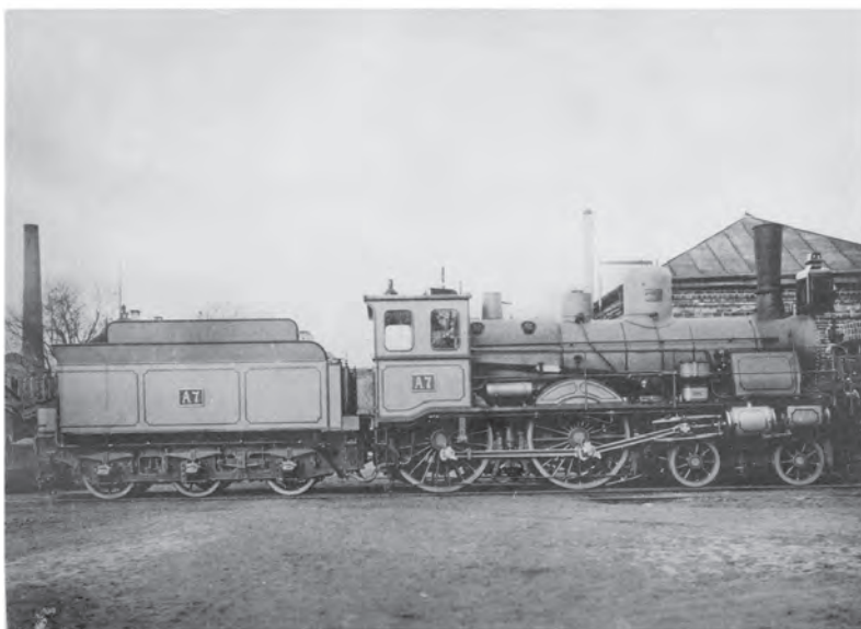
Типъ № 83. Пассажирскій паровозъ „Тандемъ Компаундъ“.
