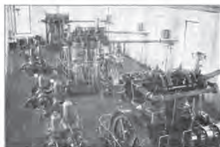
Насосная станція керосинопровода Баку-Батумъ, сооруженная въ 1905 г.
