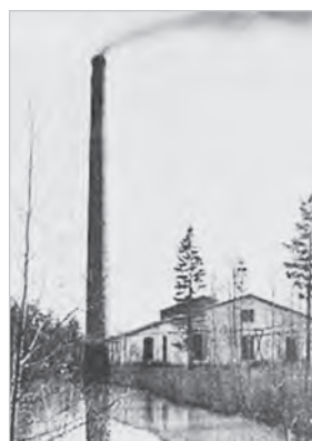
Главная электрическая станция заводов Русского общества для выделки и продажи пороха
