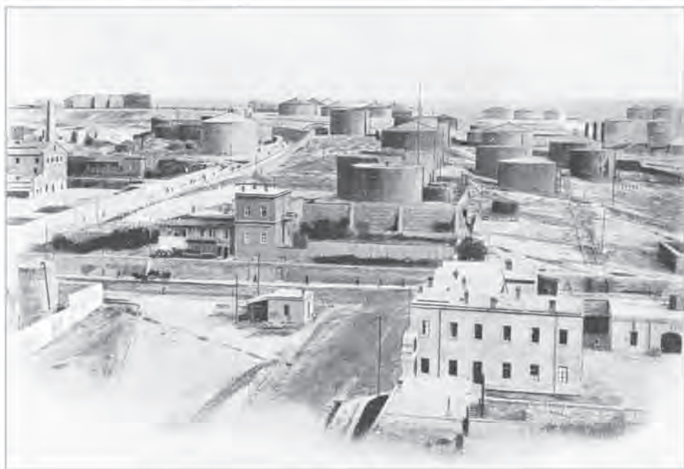
Керосиновые резервуары на заводѣ Т-ва въ Баку.
